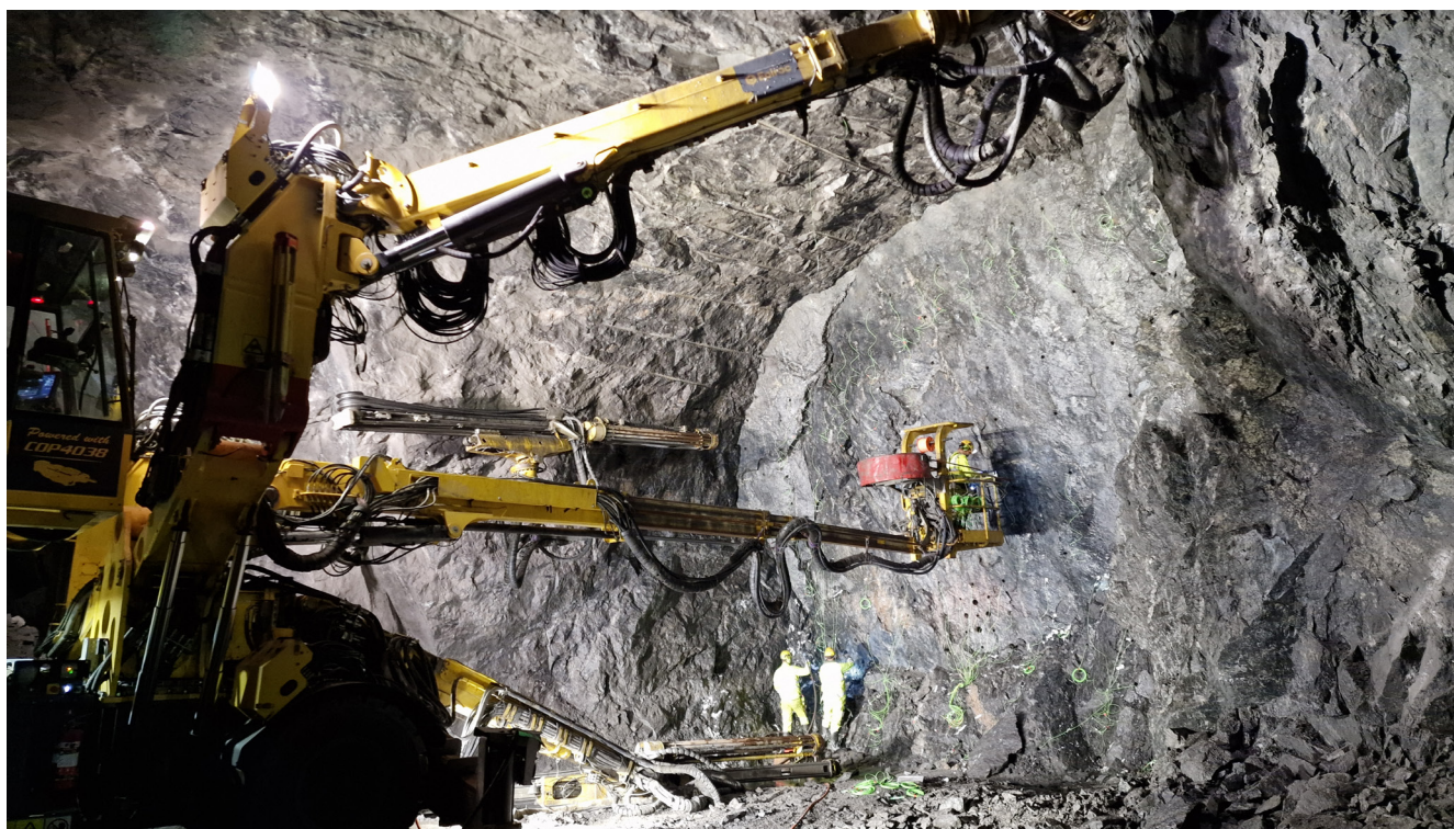
Tunnellarbeten för nya tunnelbanan i Högdalen.
